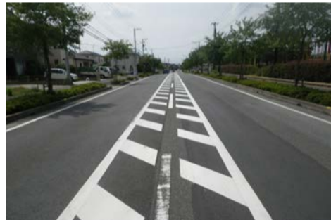
舗装補修（舗装工事は美南4丁目、栄町を含め8か所）
