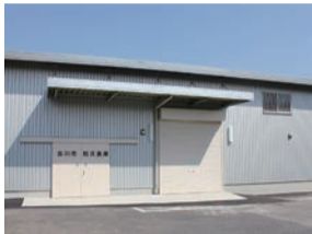
前平沼公民館跡地に防災倉庫設置
