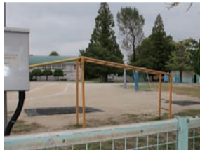
旭小、三輪野江小に耐震性貯水槽設置、市内4つの小学校に災害用便槽を整備
