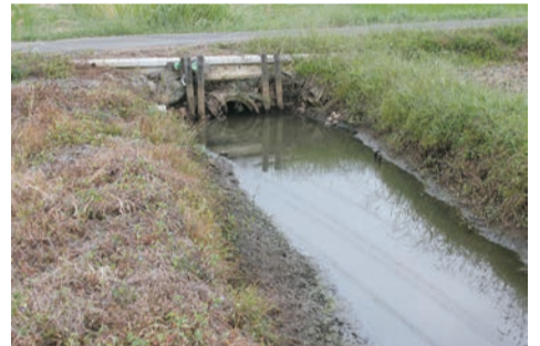
用排水路整備（測量は富新田、工事は三輪野江を含む3か所）
